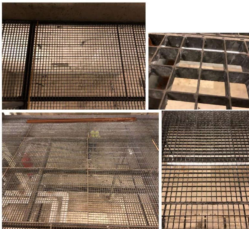
Gitterrister: Dim: 990 x 1490 mm, maskevidde: 35 x 35 mm, profilhøyde: 25 mm. Antall: 38 stk
